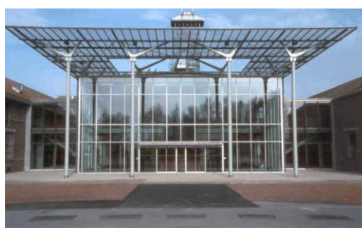
Bâtiment d'accueil © Centre Historique Minier
